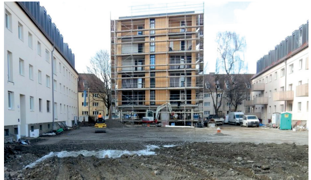
Aussenansicht während der Bauphase.
